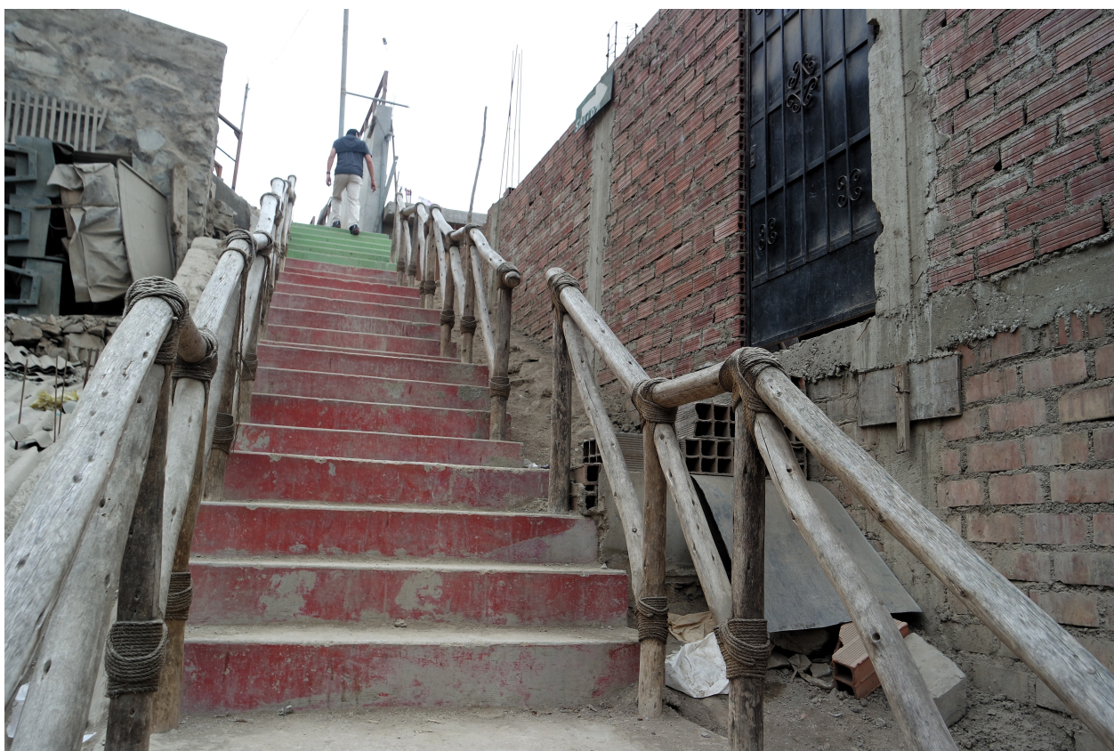
Figura 3. Escalera construida a través de dos proyectos de inversión pública confluyentes, uno promovido por la Municipalidad Metropolitana de Lima y el otro por la Municipalidad Distrital de Ate (2015). Fuente: Autores
